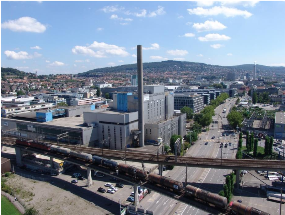
Bild 4.1 Toni-Areal vor dem Umbau
