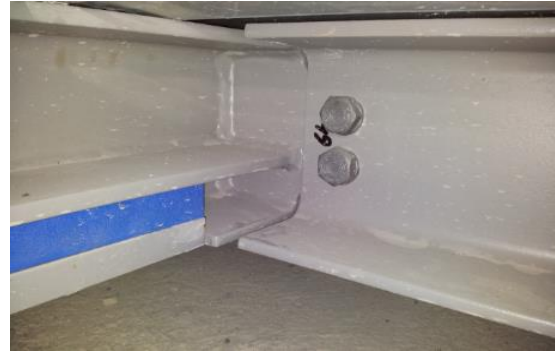
Bild 5.2 Elastisches Lager des Konzertsaals
